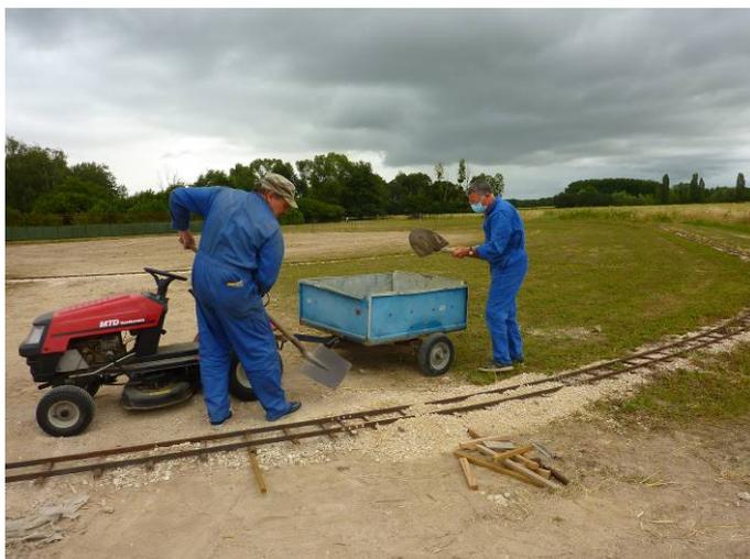
Deux sections de voies avaient été démontées pour le passage de l'engin, qu'il fallut remettre en place avec calage des voies pour permettre les circulations.
